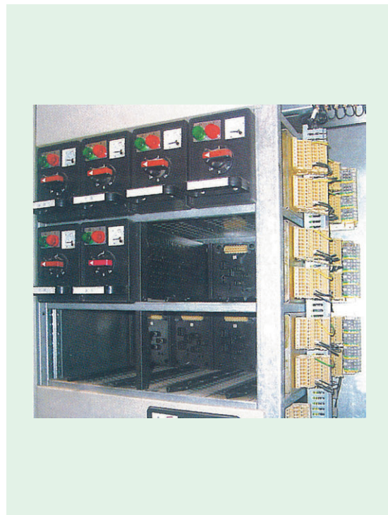
8E / 4、 8E / 2 Small device room、 cable and control line connection (side outlet)
